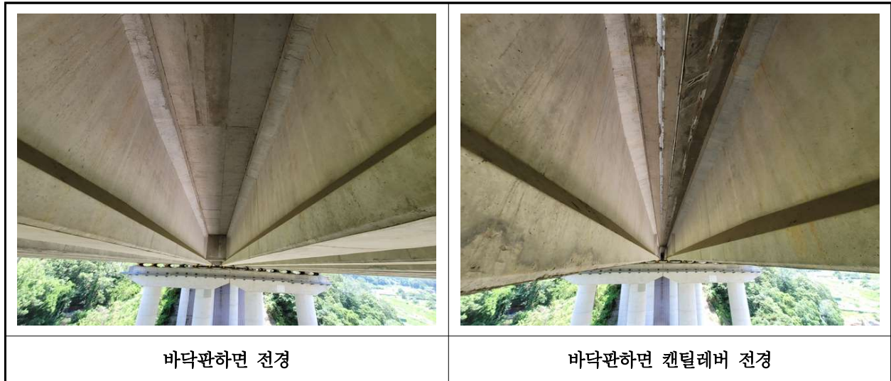
【사진 18.3.2】 바닥판하면 전경
