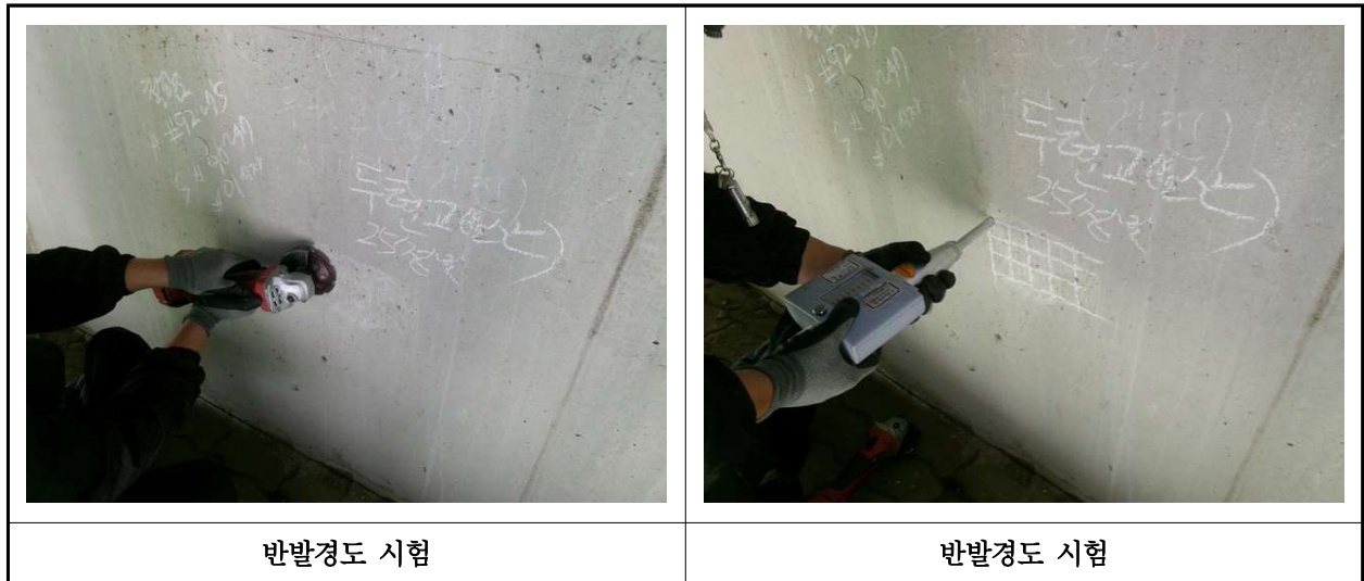
【사진 18.4.2】 반발경도시험 현장사진
