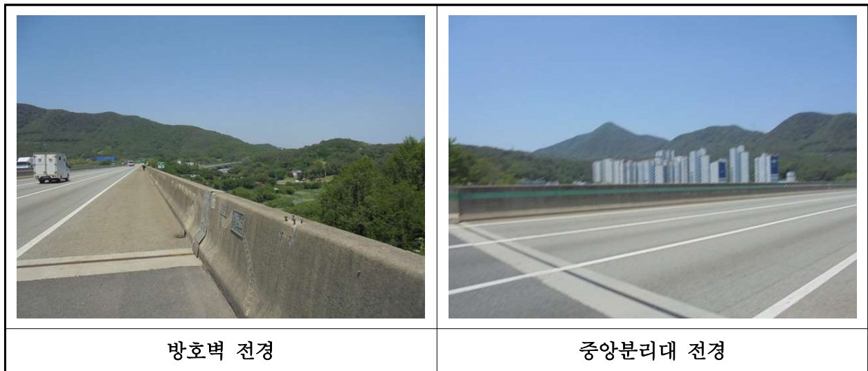
【사진 18.3.24】 방호벽 및 중분대 전경
