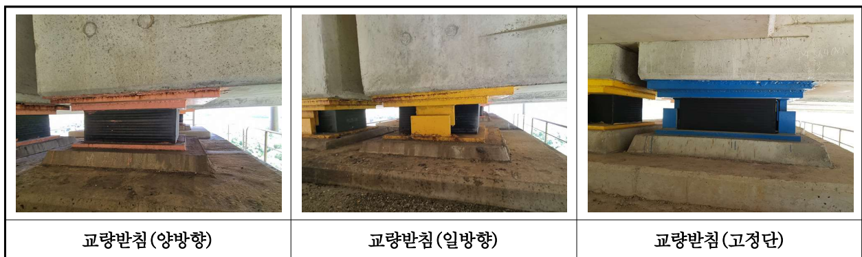
【사진 18.3.13】 교량받침 전경
