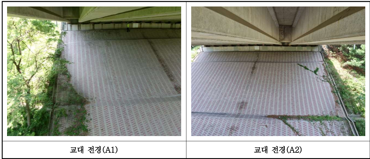
【사진 18.3.8】 교대 전경
