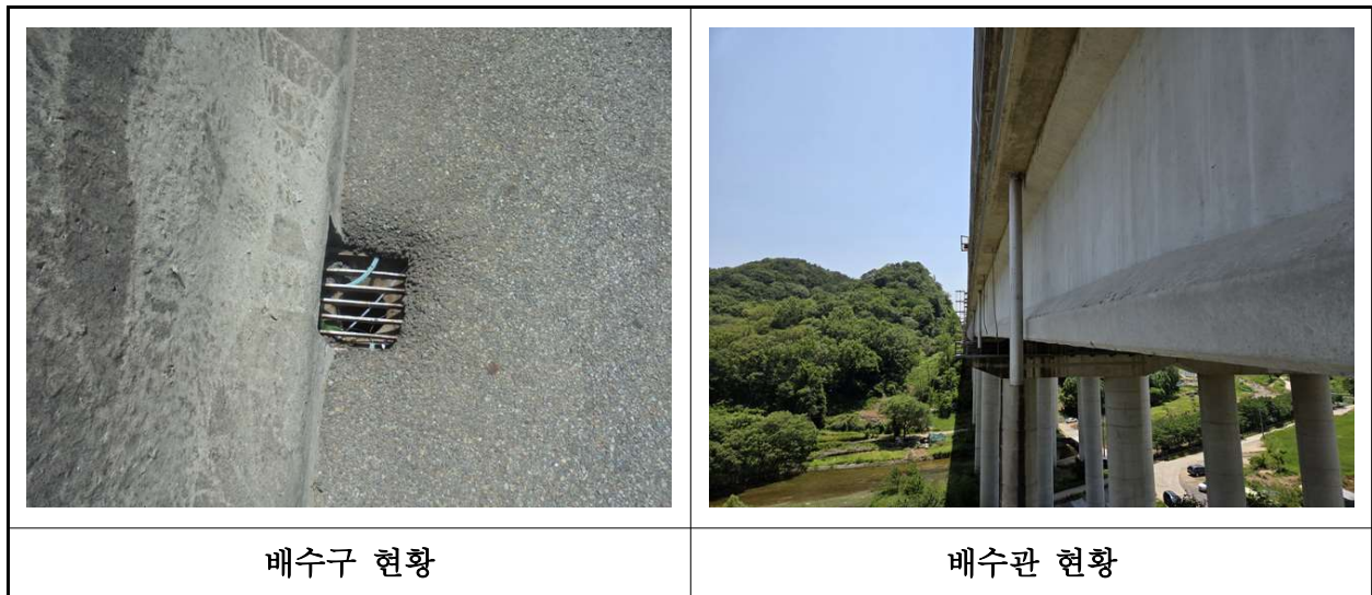
【사진 18.3.22】 배수시설 전경
