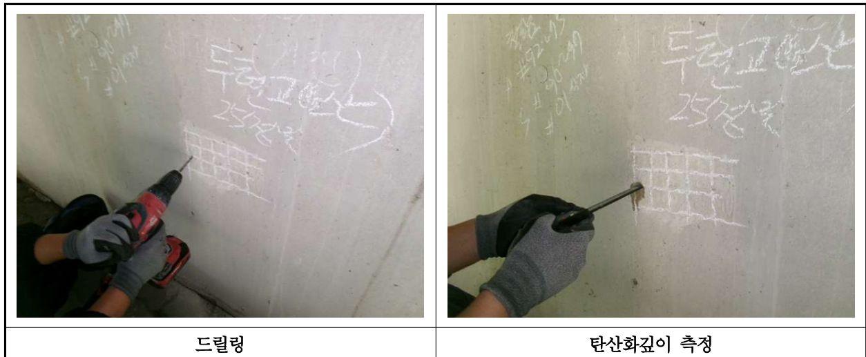
【사진 18.4.3】 탄산화 깊이 측정 현장사진
