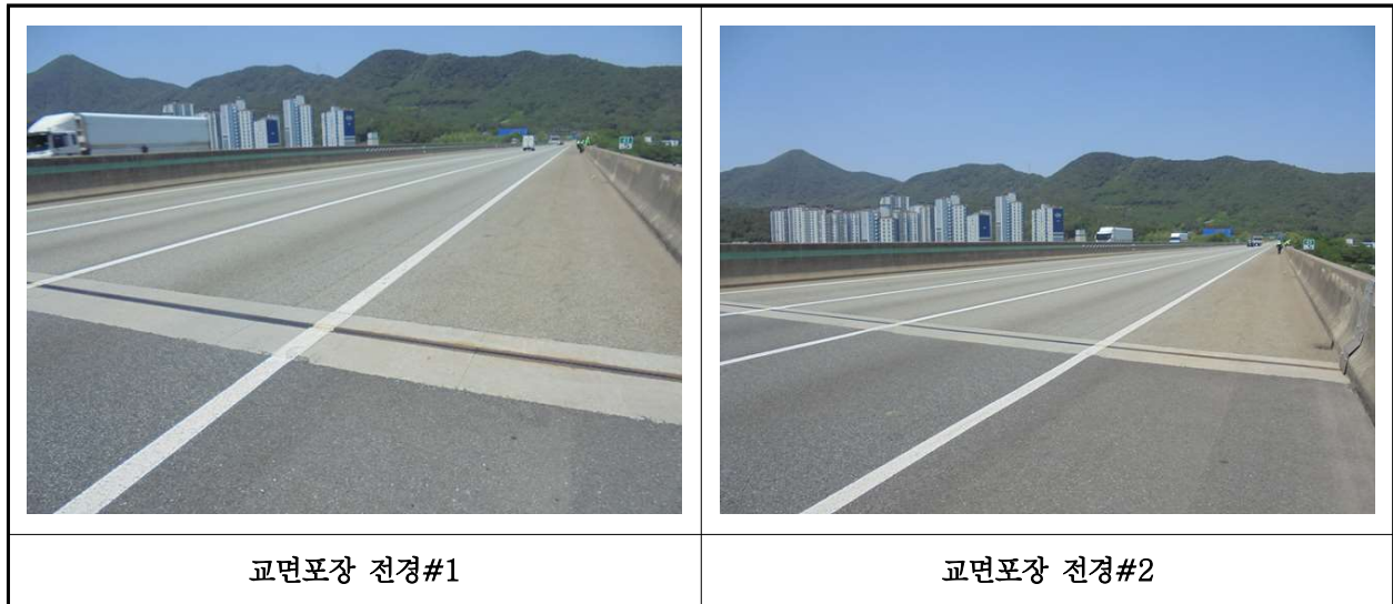
【사진 18.3.20】 교면포장 전경
