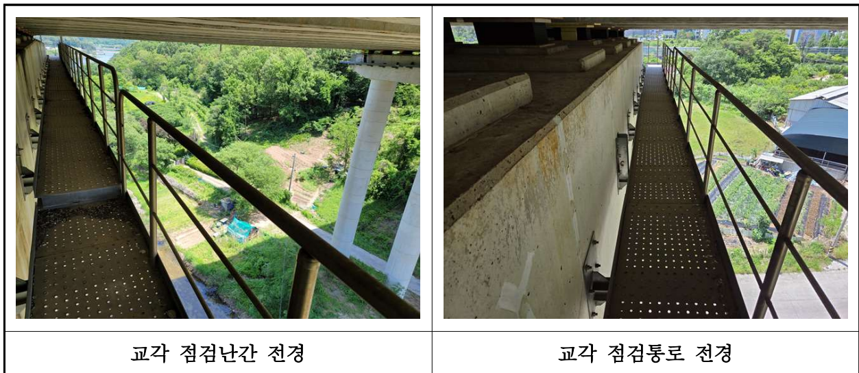
【사진 18.3.26】 교량 점검시설 전경
