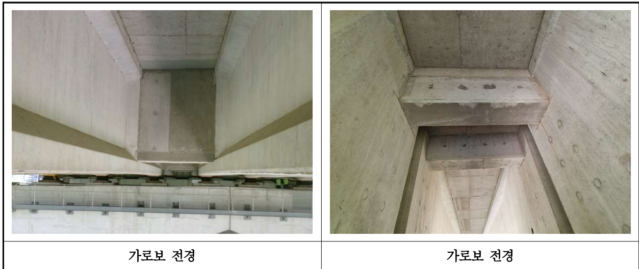
【사진 18.3.6】 가로보 전경
