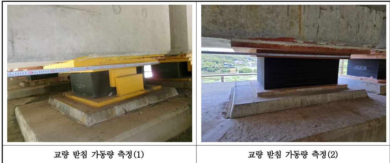
【사진 18.3.16】 교량받침 이동량 측정
